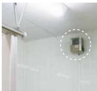
トイレ・汚物処理室
